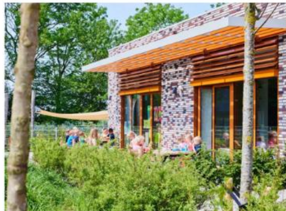
zitplekken met picknicktafels op terrassen voor de lokalen
